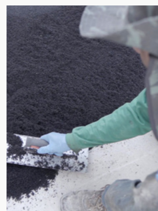
Passo 3 Camada de amortecimento SBR
